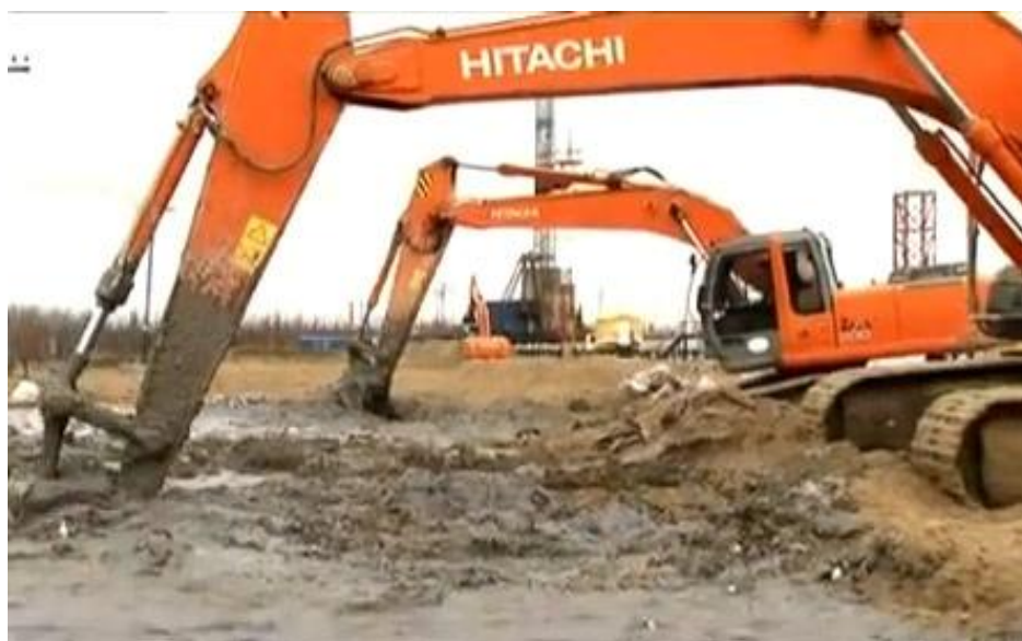
Рисунок 2.5 – Работа экскаватора по перемешиванию загрязненного грунта
