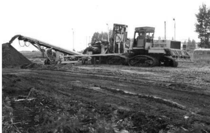
Рисунок 5.12 – Проведение полевых испытаний зубьев с КЭП на траншейном экскаваторе ЭТЦ-3661
